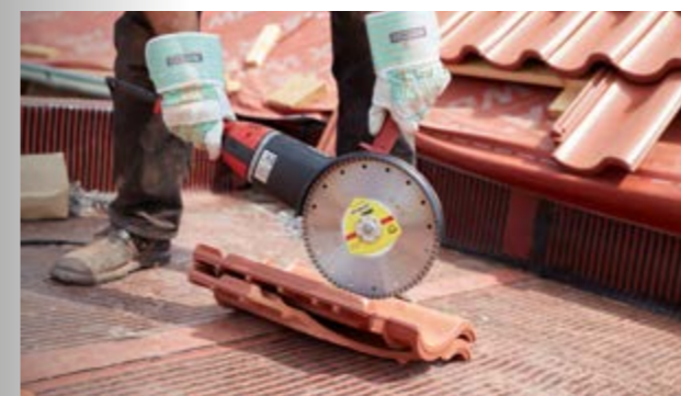
Trabajos de techado
