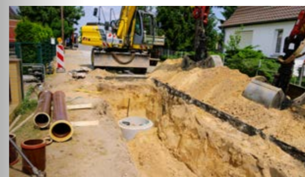
Construcción de conductos y tuberías
