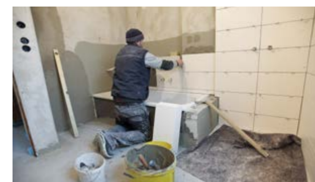
Colocación de baldosas e instalaciones sanitarias
